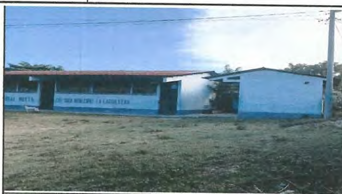
Foto 2: Área a ser intervenida con la instalación del portón de acceso.
